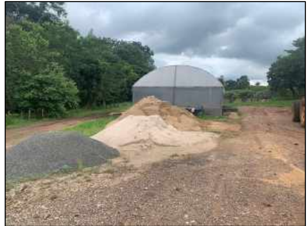
Materiais indevidamente depositados no local. Sugere-se a determinação de espaço devidamente delimitado e protegido para o seu armazenamento.
