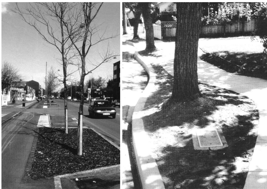
Figura 2. Exemplo: Tanto em A como em B ocorreram mudanças nas guias para obter mais espaço para o plantio de árvores de grande porte sem danos para infraestruturas urbanas.
